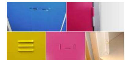
Oméga de renfort / Portes indégondables en position ouverte et fermée / Aérations haute et basse / Porte étiquette / Pastille amortisseur de bruit
